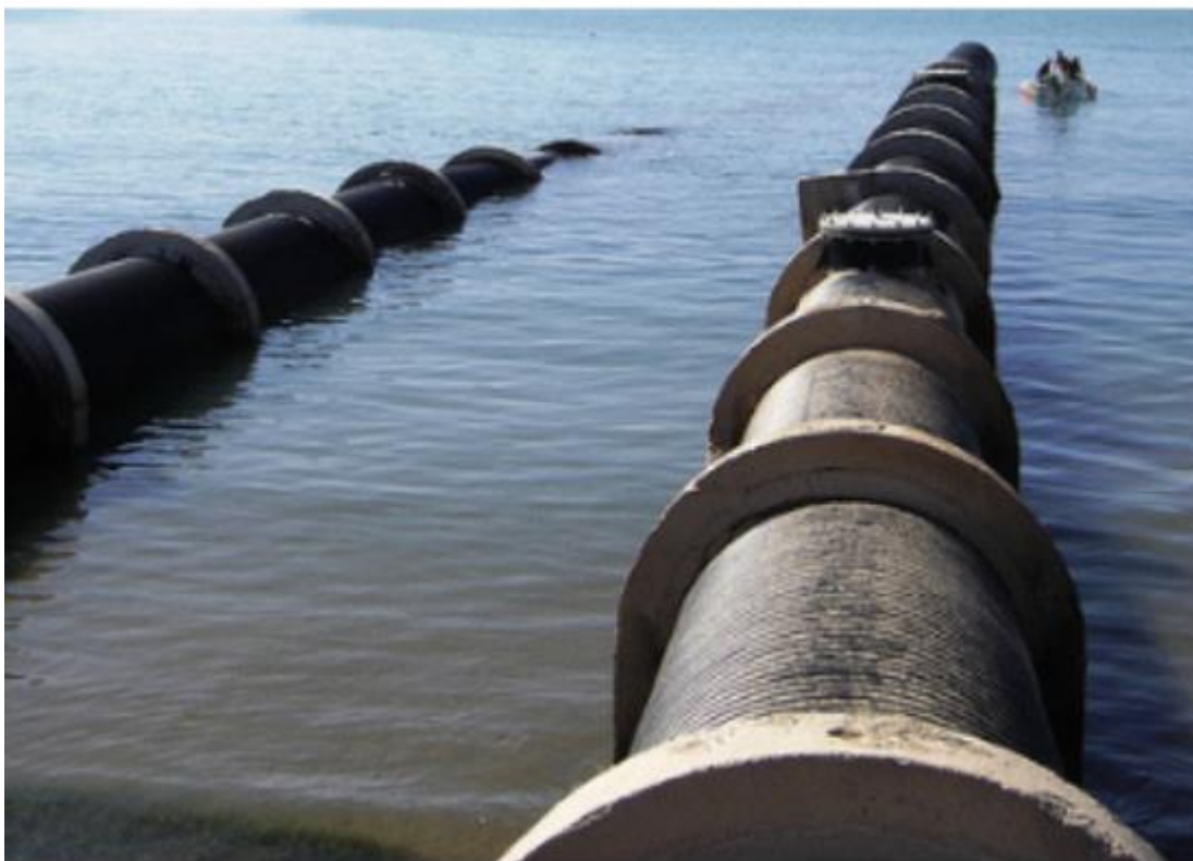
Emissário submarino. Na imagem é possível observar as tubulações assentadas no fundo marinho, que transportam os efluentes e lançam todo o esgoto em alto mar.
